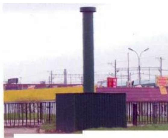
Рис. 2.8 б. Кассетный фильтр на камере Восточного канала возле метро Выхино (после реконструкции)
